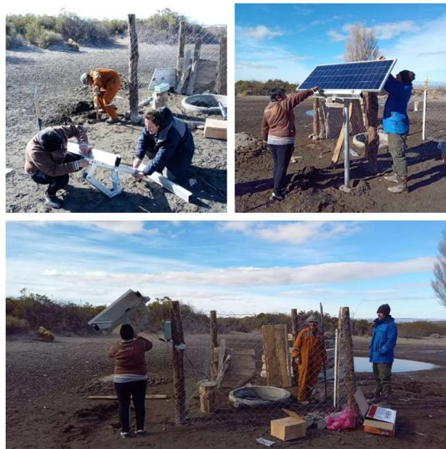
**Figura B.22.** Sistema de bombeo solar, instalación mantenimiento y funcionamiento en Paraje Barda Negra
