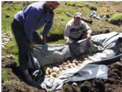
**Figura B.15.** Recubrimiento con piedras del lugar del caño ranurado previo a terminar de envolverlo con la malla de geotextil.
