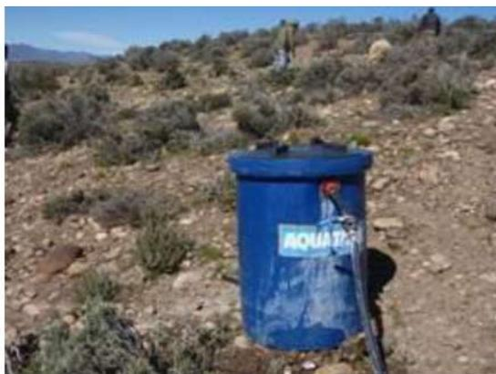
**Figura B.17.** Tambor rompecarga para evitar sobrepresiones en el sistema que puedan romper cañerías y uniones de manguera.
