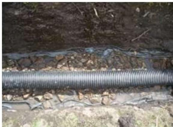
**Figura B.13.** Caño ranurado apoyado sobre una base de geotextil y piedra
