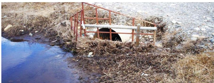
**Figura C.25.** Obturación de alcantarilla por castorera de *Castor canadensis*. Foto: Julio Escobar
