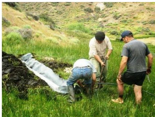
**Figura C.18.** Mejoras en la provisión de agua: Instalación de tubo filtrante en mallín, paraje cordillera de Ranquilhuao. Foto: Equipo SP Cushamen
